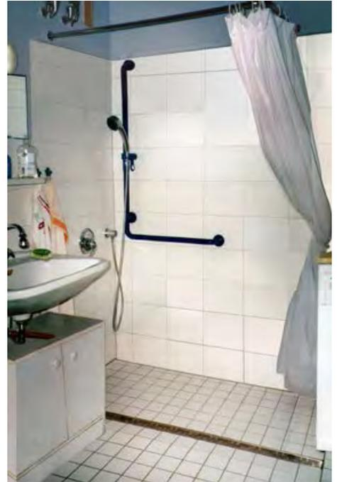
Das Entfernen von Schränken unter dem Waschbecken ermöglicht ein Waschen im Sitzen. Um das Unterfahren mit einem Rollstuhl zu ermöglichen, sollte ein **Unterputz-** oder **Flachaufputzsiphon** eingebaut werden
