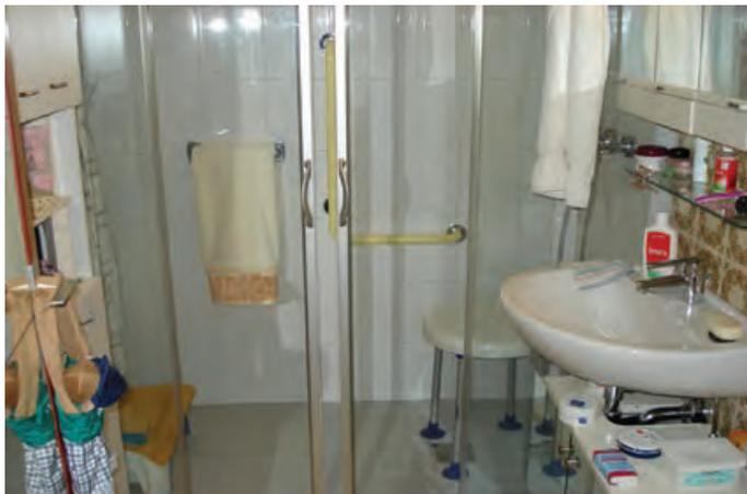
**Bodengleiche Duschen** (ohne feststehende Elemente und vollständig nach außen zu öffnenden Türen) erleichtern die Nutzung
