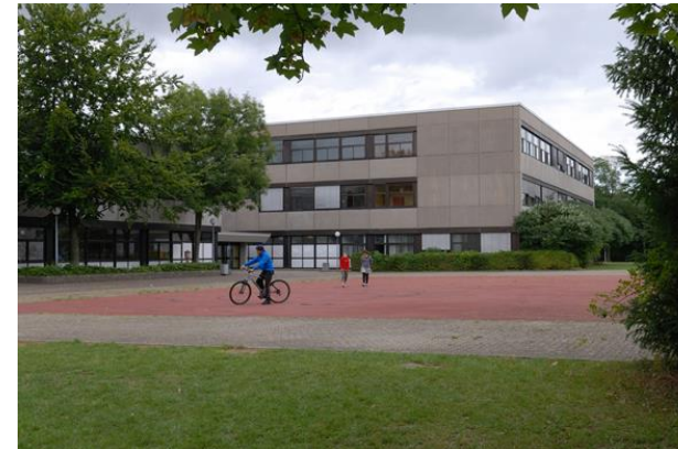
Heinrich von Brentano Schule, Hochheim Modulgebäude 2,9 Mio. €
