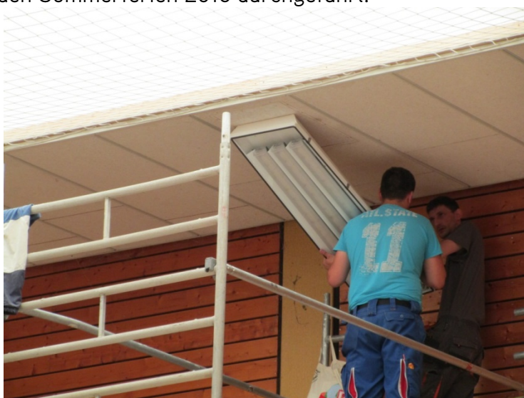
Abb. 7: Einbau LED-Leuchte RIDI in die Sporthalle der Heinrich-von-Kleist-Schule
