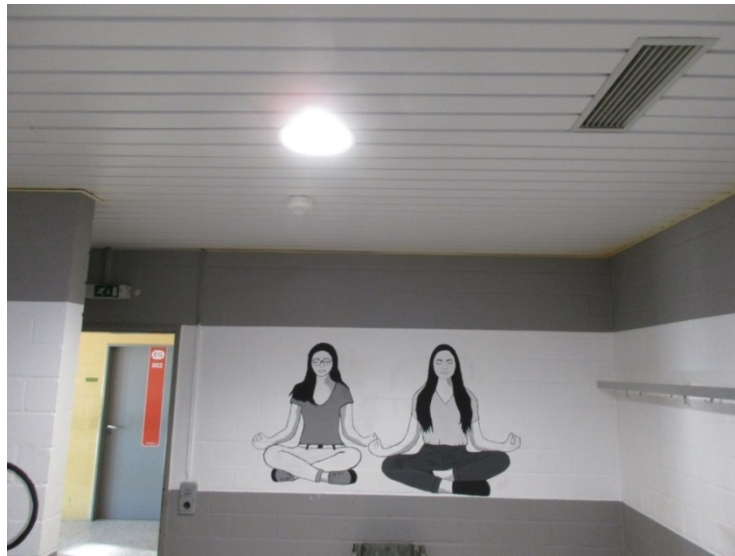
Abb. 6: Umkleideraum Sporthalle: LED-Beleuchtung mit Präsenzmelder
