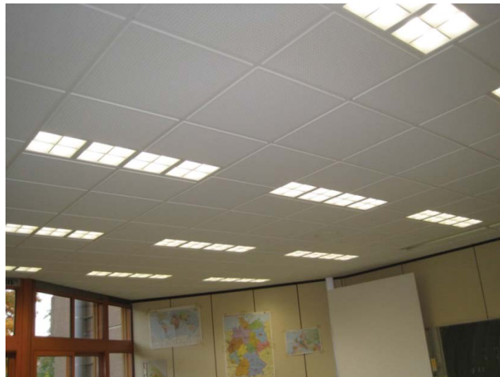
Abb. 5: Albert-Einstein-Schule, Klassenraum mit neuer LED-Beleuchtung
