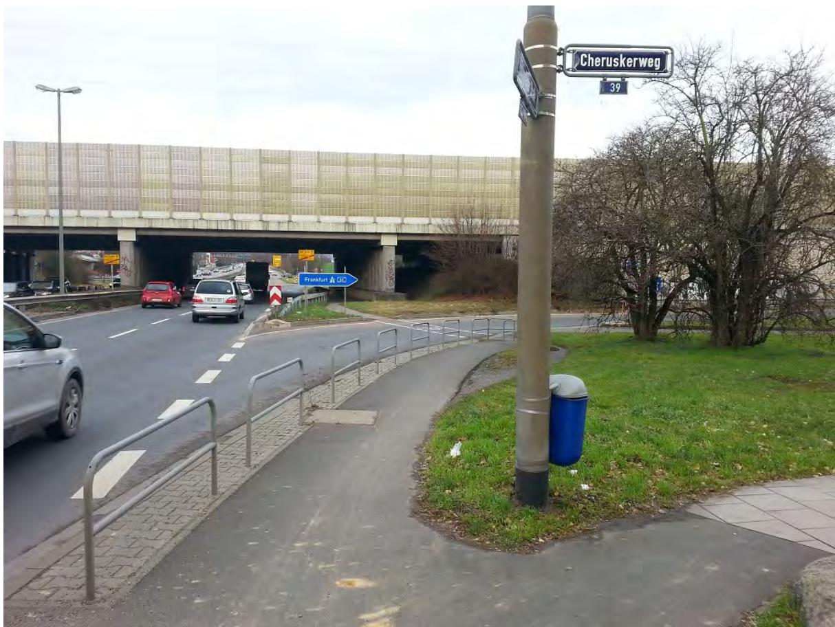
Abbildung 5: Führung des Radverkehrs entlang der B 8 in Richtung Sulzbach.
