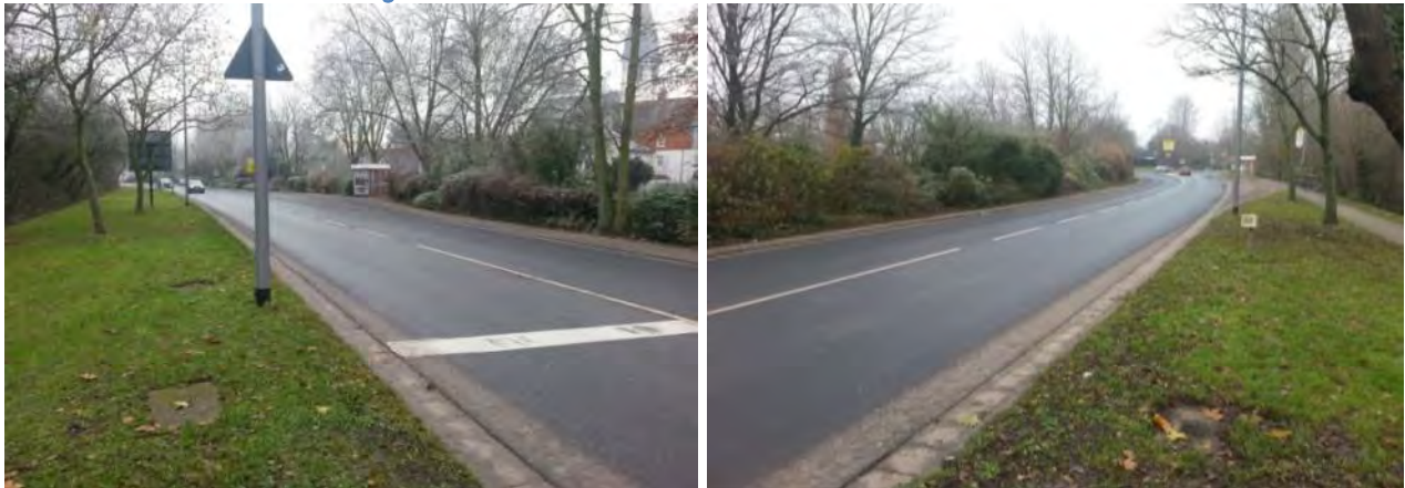
Abbildung 45: Hessendamm in Hattersheim.
