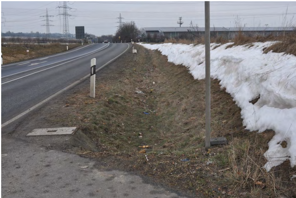
Abbildung 11: Streckenabschnitt zum Ausbau des Mehrzweckstreifens.
