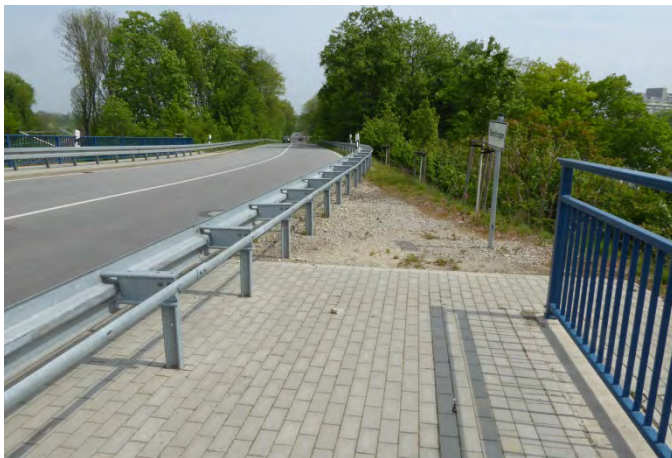
Abbildung 46 L3265 Brücke Bild 1
