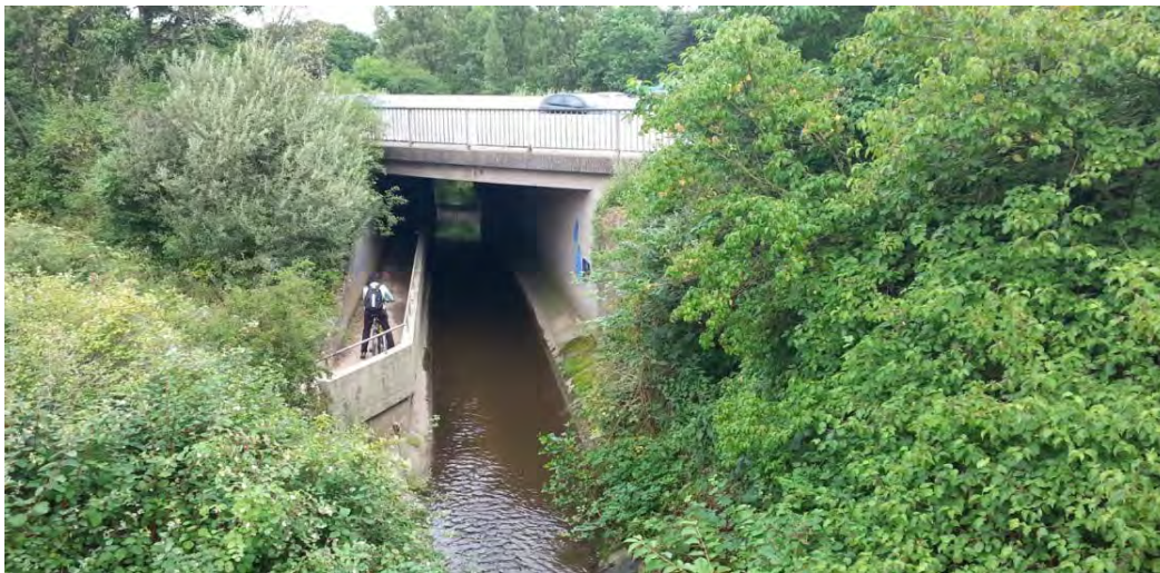
Abbildung 4: Unterführung der A 66 am Sulzbach.
