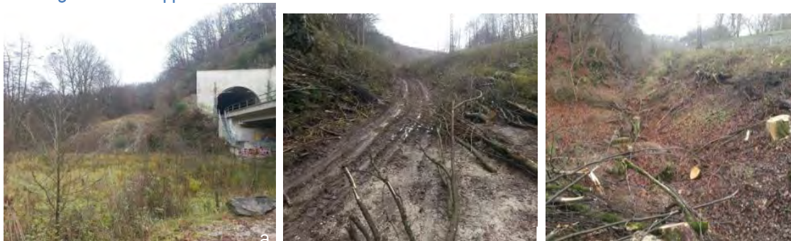
Abbildung 25: Blick vom westl. Tunnelkopf nach Norden (Teil 1, a), Gelände entlang der Bahnstrecke (Teil 2, b+c).
