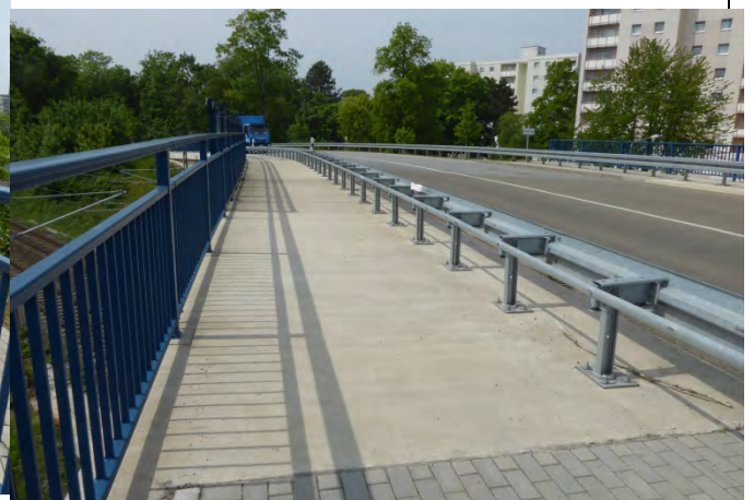
Abbildung 47 L3265 Brücke Bild 2
