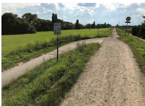
Abbildung 1: Bestehender Deichverteidigungsweg an der Grenze zwischen Flörsheim und Hattersheim.
