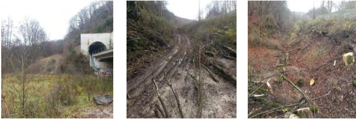
Abbildung 26: Blick vom westl. Tunnelkopf nach Norden (Teil 1, a), Gelände entlang der Bahnstrecke (Teil 2, b+c).
