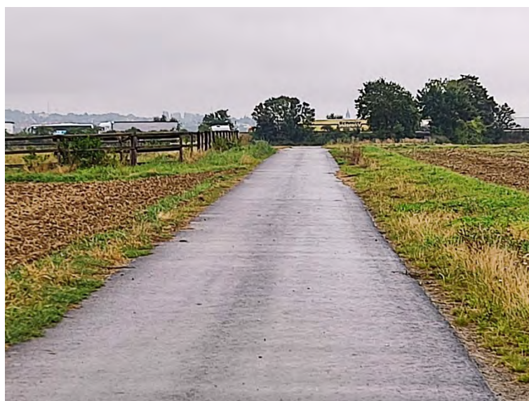
Abbildung 55: Asphaltdecke Diedenbergerer Weg.
