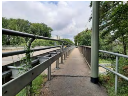
Abbildung 35: Gehweg Sossenheimer Str., Brücke über die L 3005
