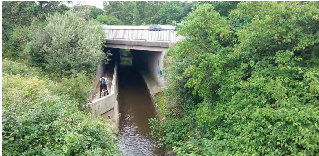
Abbildung 6: Unterführung der A 66 am Sulzbach.
