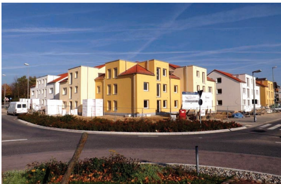
Neubauvorhaben der HWB im Kiebitzweg in Hofheim-Diedenbergen
