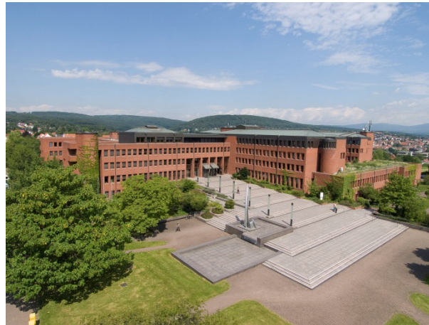
Landratsamt, Am Kreishaus 1-5, 65719 Hofheim
